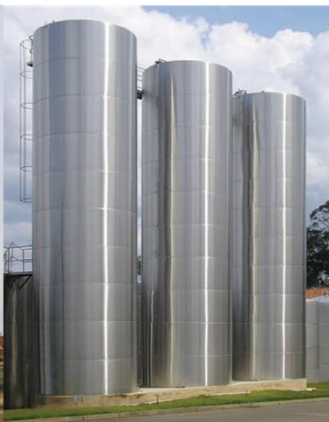
Reservatório para água
