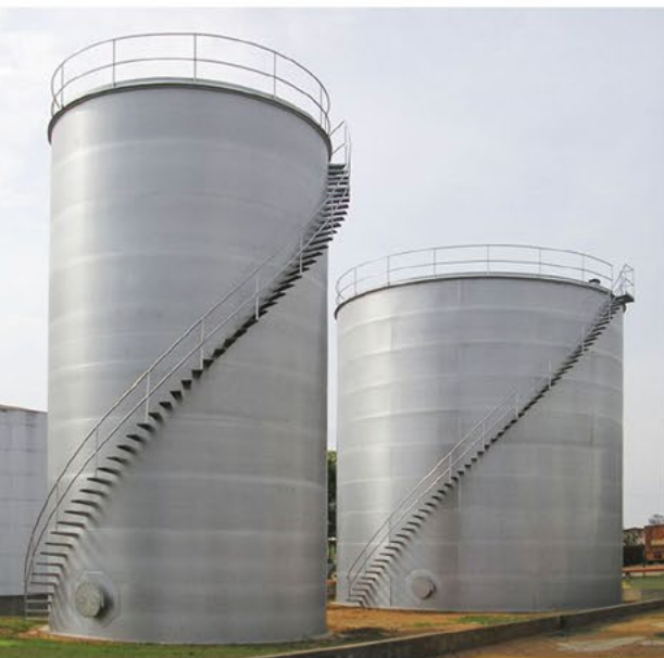
Reservatório para destilado
