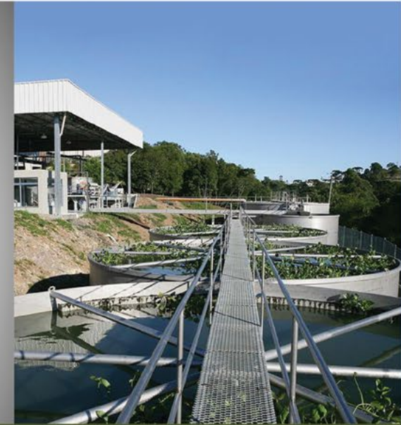
Tratamento de efluentes
